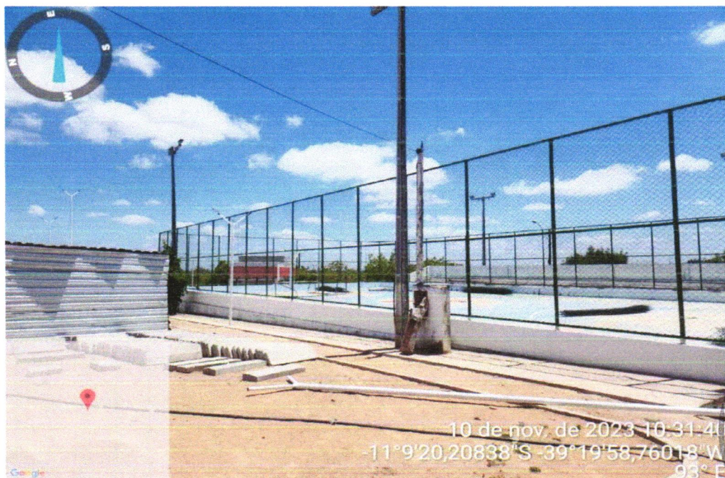
Foto 10- EXECUÇÃO DOS POSTES E ALAMBRADO
