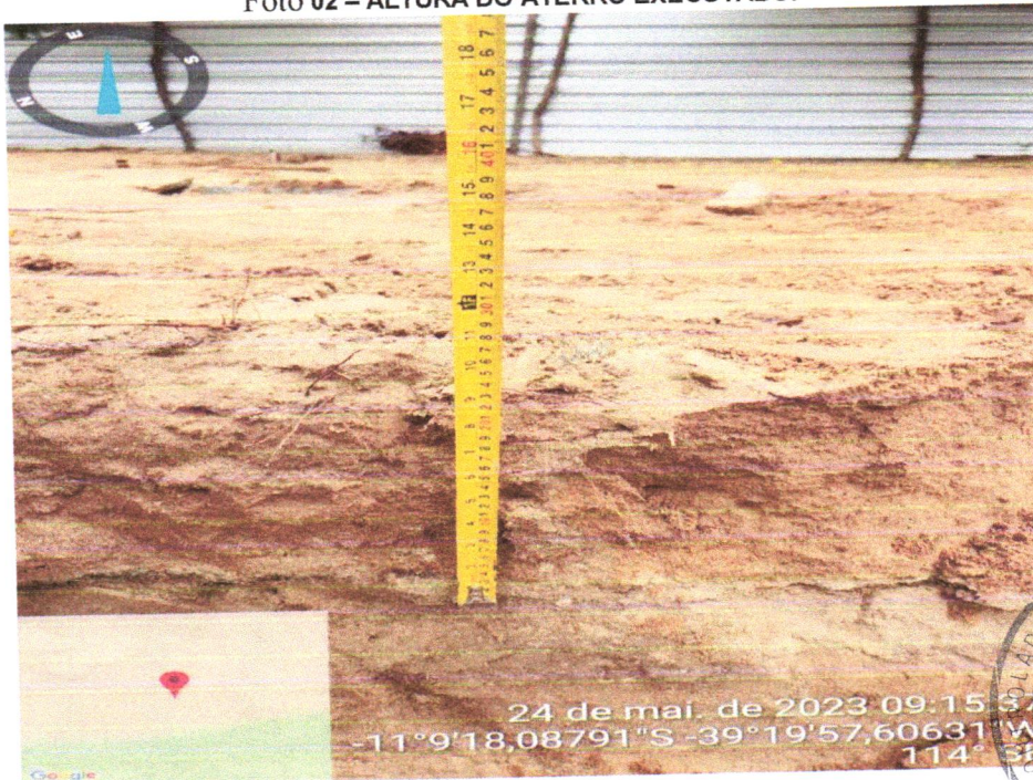
Foto 02 – ALTURA DO ATERRO EXECUTADO.
