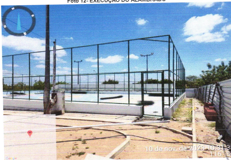
Foto 12- EXECUÇÃO DO ALAMBRADO
