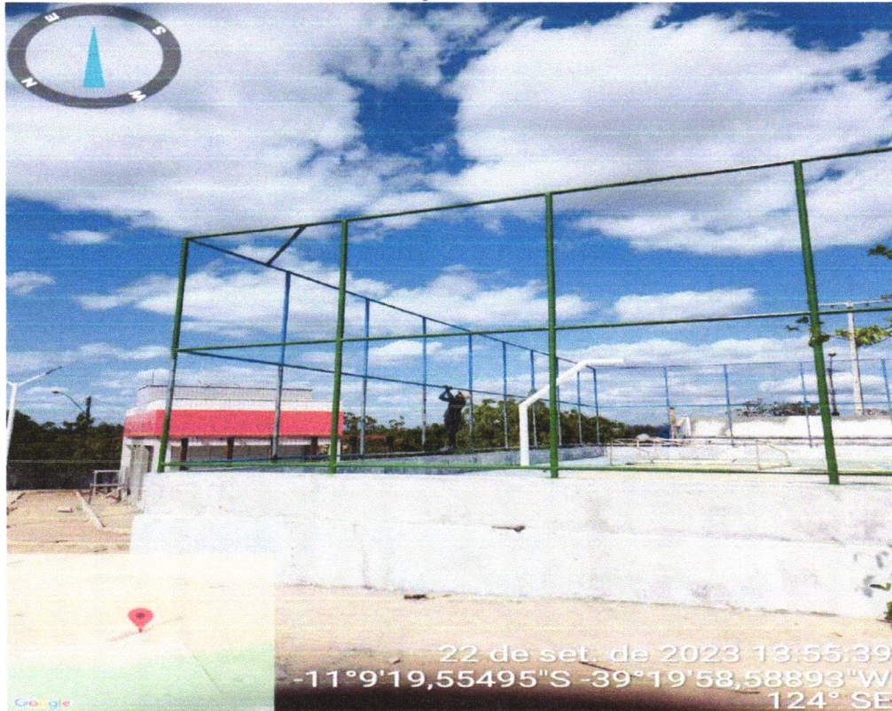
Foto 10- EXECUÇÃO DOS POSTES E ALAMBRADO
