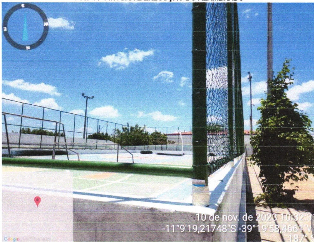
Foto 14- PINTURA E EXECUÇÃO DO ALAMBRADO
